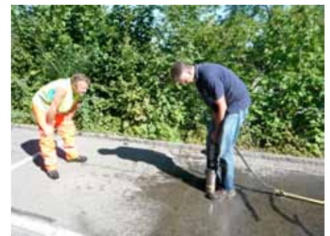
Zum Internet of Things gehören zum Beispiel Sensoren, die die Belegung von Parkplätzen erfassen und die Information an das Parkleitsystem melden. Im Bild: Bohrarbeiten für die Verlegung der Sensoren in einen Pilotprojekt in Lenzburg. Die batteriebetriebenen Sensoren benötigen lediglich ein Bohrloch; eine weitere Verkabelung ist nicht nötig. Foto: Swisscom, André Portner
